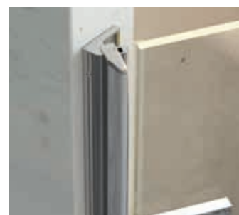
WPT-Profil zur Befestigung der Tür auf der Bandseite im Winkel
